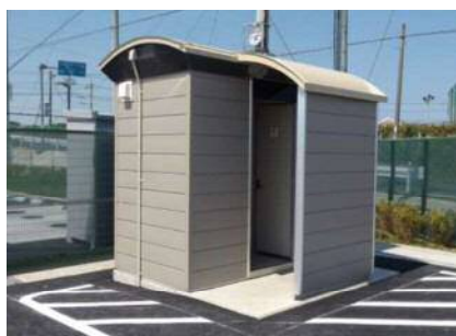
多目的グラウンド トイレ
